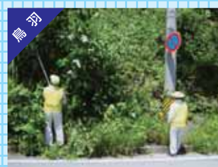
安全施設の点検と草木刈り
