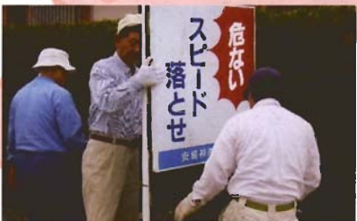
支部役員が道路標識の点検・補修を実施 (鶴殿地区交通安全協会)
